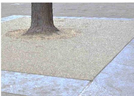
**terrasystem<sup>®</sup>** Beläge sind aufgrund ihrer Wasser- und Luftdurchlässigkeit für Baumscheiben geeignet. Der Wurzelraum wird begebar ohne die Fläche zu versiegeln.
